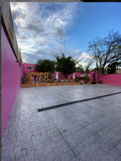
SOBRE CONCRETO ESTAMPADO
