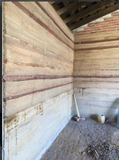
SOBRE MURO DE TIERRA COMPACTADA
