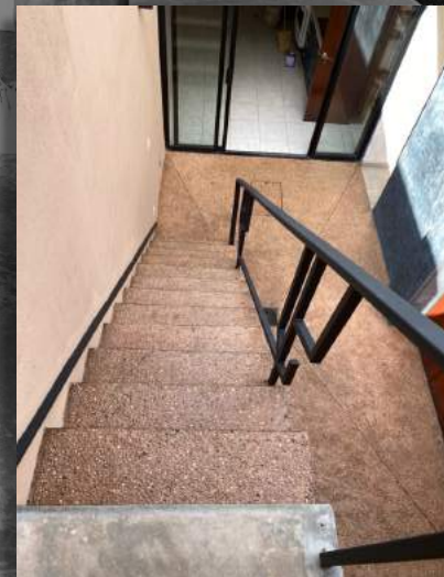
SOBRE CONCRETO MARTELINADO/LAVADO
