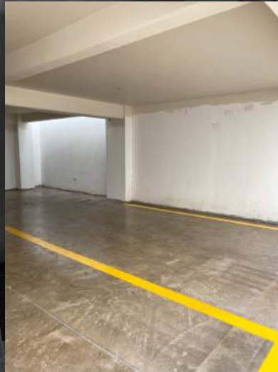
SOBRE PISOS ESTACIONAMIENTO
