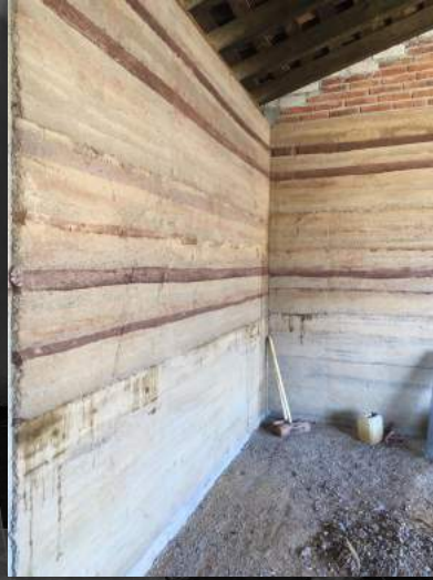
SOBRE MURO DE TIERRA COMPACTADA
