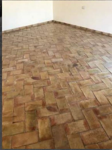
SOBRE PISOS DE LADRILLO
