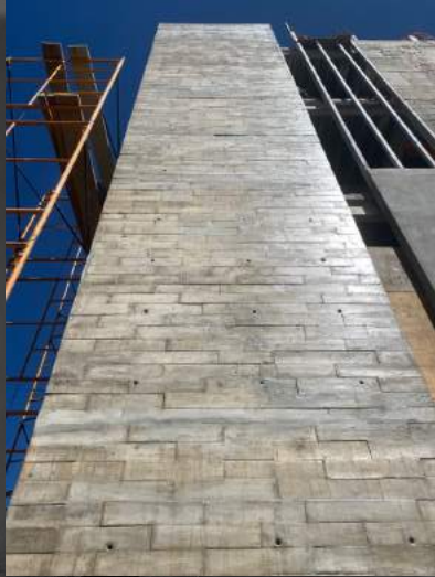
SOBRE CONCRETO ENDUELADO APARENTE
