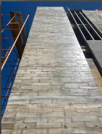
SOBRE CONCRETO ENDUELADO APARENTE
