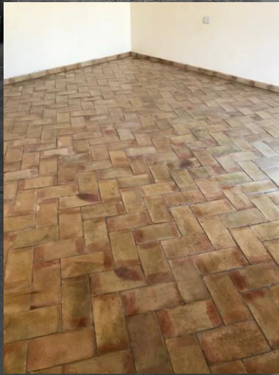
SOBRE PISOS DE LADRILLO
