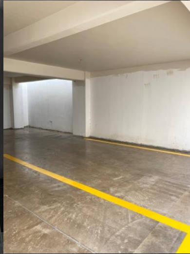
SOBRE PISOS ESTACIONAMIENTO
