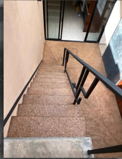
SOBRE CONCRETO MARTELINADO/LAVADO
